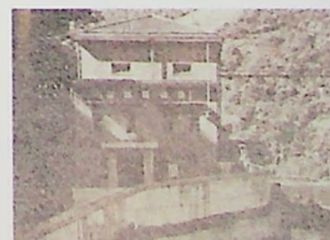
光復後完成第一部裝機之烏來發電所
