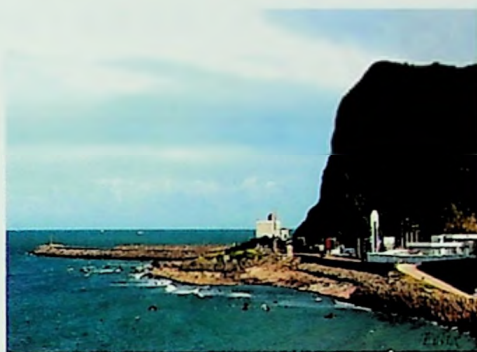
核一廠機組冷卻水進水口
