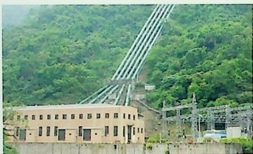
日月潭第一發電所（今大觀一廠）
