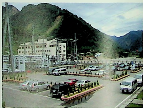
天輪發電廠現貌
