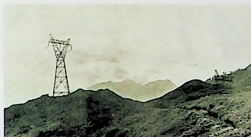
東西連絡線於民國 39 年 10 月興建，41 年完成木塔、42 年完成鐵塔工程
