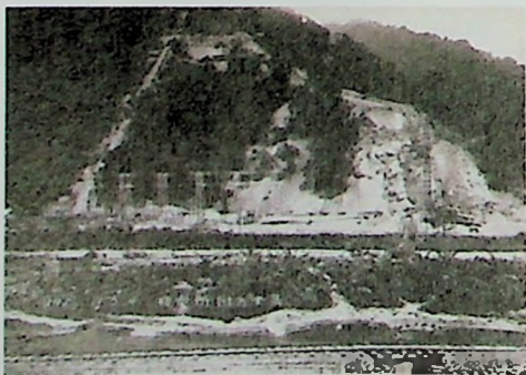
明潭發電廠鉅工分廠之前身為日月潭第二發電所，於24年開工。總統巡視，以電力設備為工業之母易名為「鉅工」。
