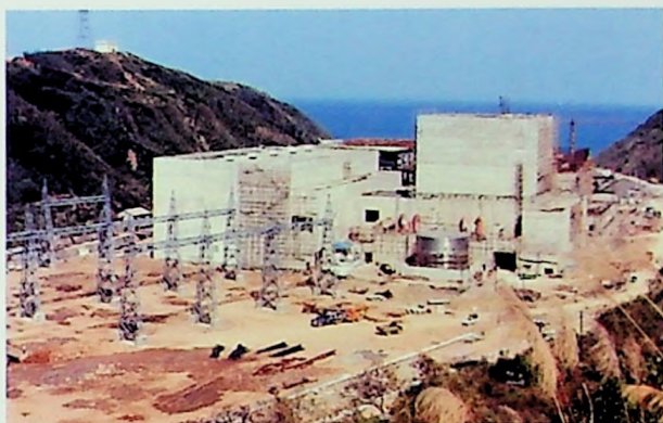
核一廠開工整地
