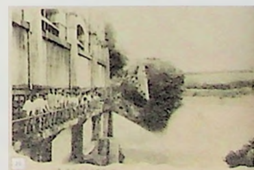
新店水力發電所
