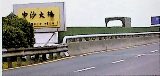
南北高速公路建橋
