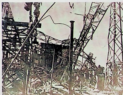
鉅工發電所被炸破壞情形之二
