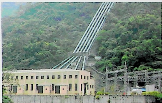
日月潭第一發電所（今大觀一廠）
